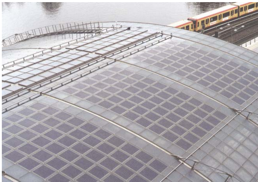
Pogled odozgo na stakleni krov
